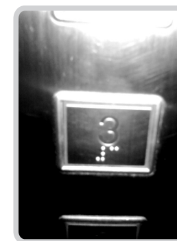
Рис. 68. Кнопки лифта с подписями шрифтом Брайля в Управлении Пенсионного фонда по Волгоградской области
