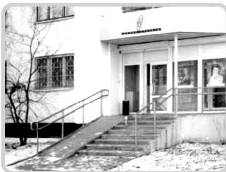
Рис. 65. Ненормативный пандус опасный для незрячих и слабовидящих
