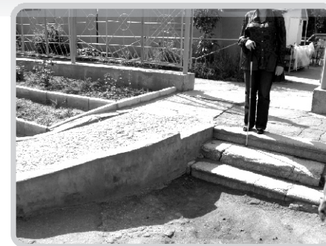
Рис. 44. Подход в здание поликлиники № 12 в Центральном районе Волгограда
