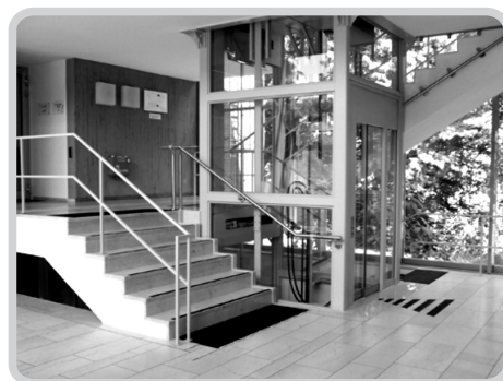
Рис. 62. Пример устройства лестницы для МГН с тактильными полосами
