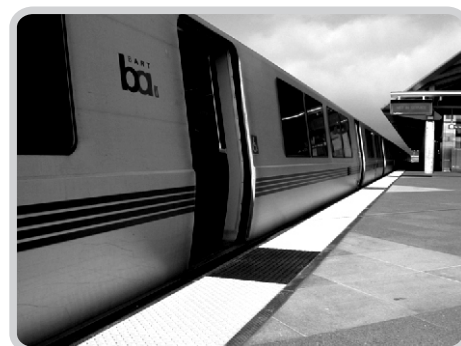
Рис. 91. Тактильная и контрастная полоса на платформе станции скоростного поезда
