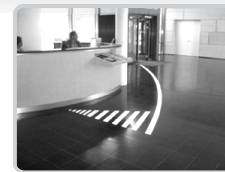
Рис. 16. Тактильный и контрастный указатель в помещении
