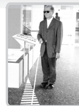
Рис. 14. Тактильный указатель места получения услуг
