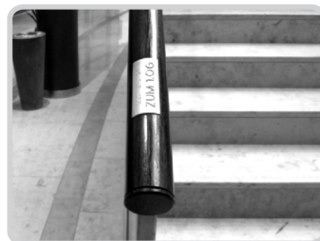
Рис. 75. Информация рельефно-точечным шрифтом Брайля и рельефными знаками на поручне лестниц
