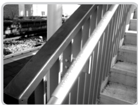
Рис. 63. Поручни для МГН, с подписями шрифтом Брайля
