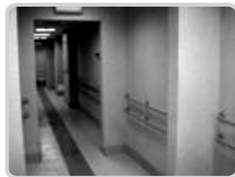
Рис. 48. Коридор с настенными и напольными направляющими для инвалидов по зрению
