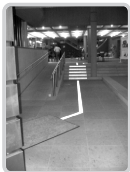
Рис. 42. Обустройство пути движения МГН
