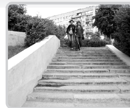
Рис. 38. Лестница не отвечающая нормативным документам, на пути движения МГН от Территориального управления социальной защиты населения по Центральному району Волгограда Администрации Волгоградской области
