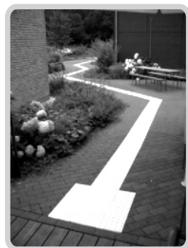
Рис. 41. Тактильные направляющие на извилистой дорожке при подходе к зданию
