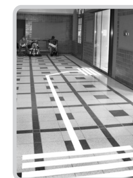
Рис. 18. Группа тактильных и контрастных указателей в коридоре
