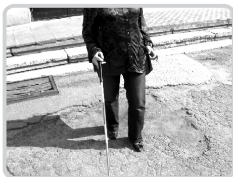
Рис. 43. Вход в здание поликлиники № 12 в Центральном районе Волгограда
