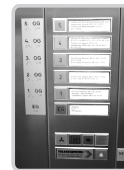
Рис. 69. Информация в лифте продублирована шрифтом Брайля
