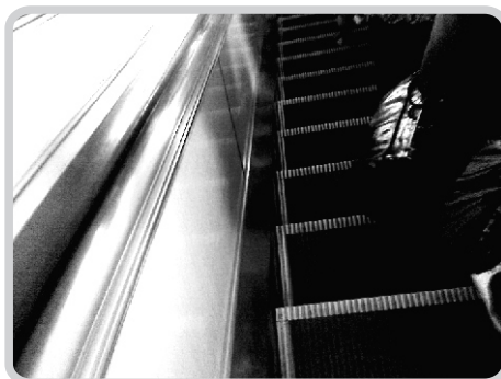
Рис. 94. Контрастная окраска краёв ступеней эскалатора в Московском метро
